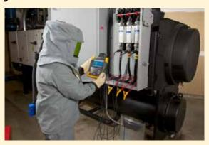
Simplemente conecte los cables de medición de tensión y las sondas de corriente flexibles al servicio de suministro del motor.
