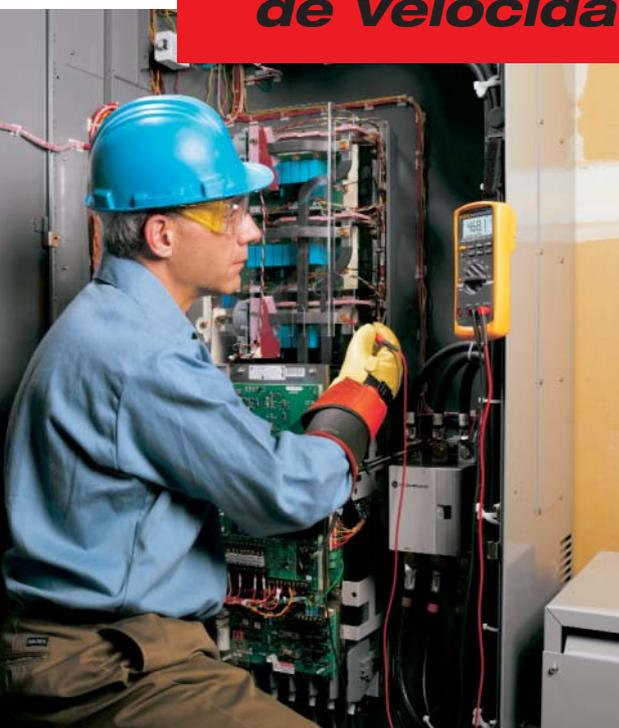
El multímetro Fluke 87V está especialmente diseñado para evitar los problemas habituales de medida en sistemas con variadores de velocidad. Estos dispositivos controlan la velocidad de giro de los motores mediante la modulación del ancho de pulso, lo que genera una señal compuesta con gran cantidad de ruido eléctrico.
