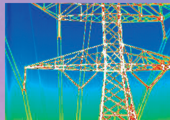
Transporte y distribución eléctrica
