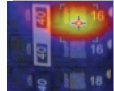
Imagen térmica combinada al 50 %
