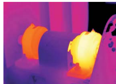
Sobrecalentamiento en un sistema mecánico
