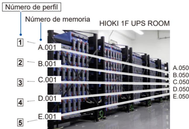
Puede guardar los datos de medición en relación con la información de perfil registrada anteriormente. Esto le facilita el control de la información, incluido los UPS equipados con baterías en medición y sus ubicaciones.
